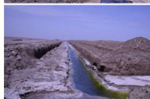
5月9日上午，第一团第一组与采卤一车间全体人员一起到现场，修复8号内部输卤渠的漏洞。经过3个小时的奋战，清理工作完成，铺上pe膜后，将投入使用。图为清理工作现场。
